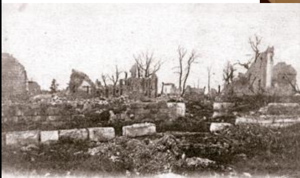
Ruines de la ferme de Quenneviers
